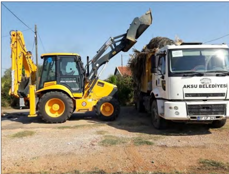
Arazi temizliği (Boş arazilere atılan moloz, çöp vb. atıkların temizlenmesi)
