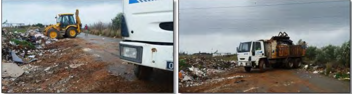
Boş alan ve arazi temizliği(Cihadiye Mahallesinden Atatürk Mh. Giden yolda bulunan molozların temizliği)
